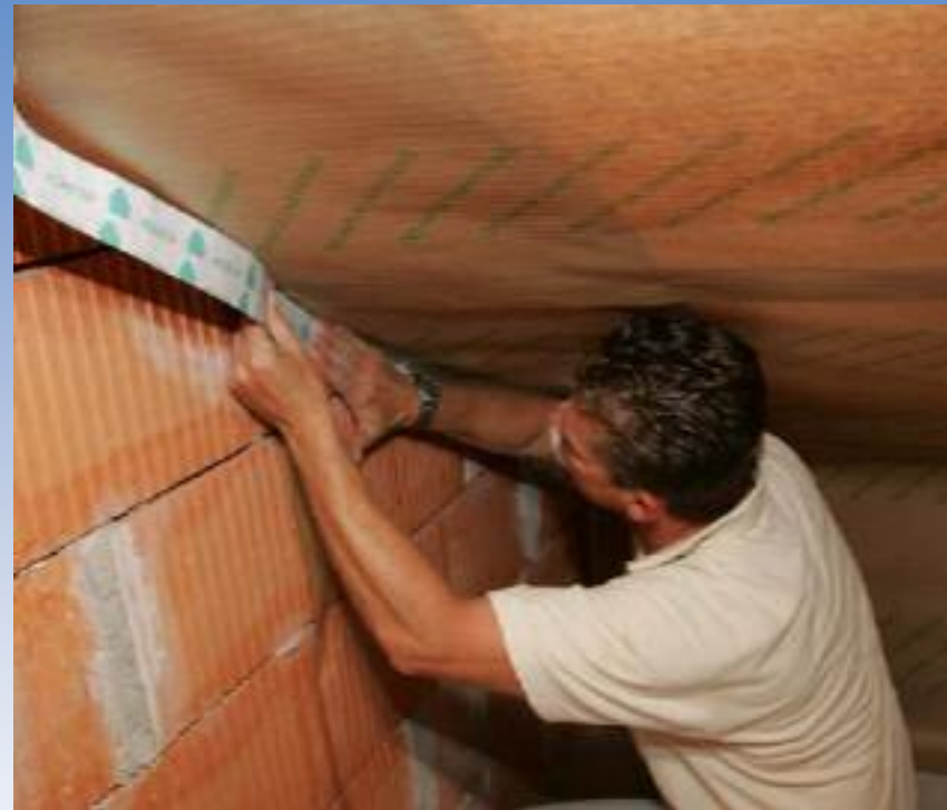
luftdichte Verklebung mit dem AIRSTOP Klebeband
