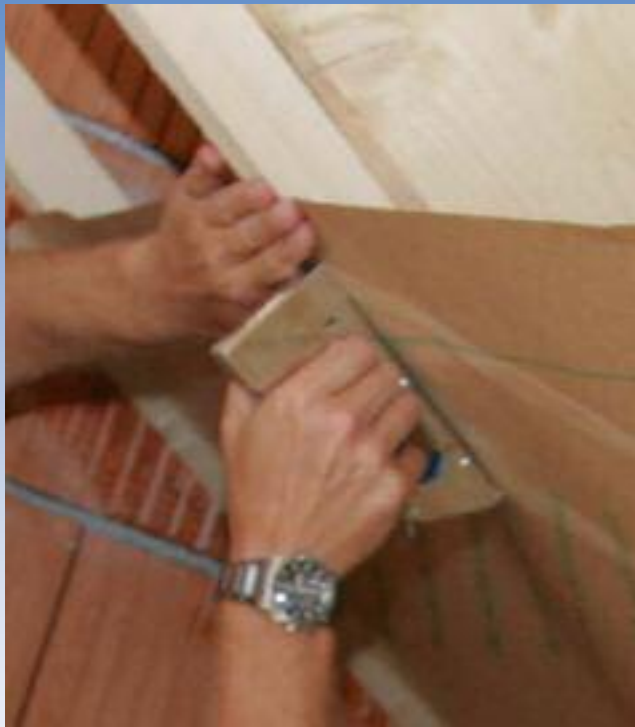
mechanisches Anbringen der ÖKO – Natur Dampfbremse mit Tacker
